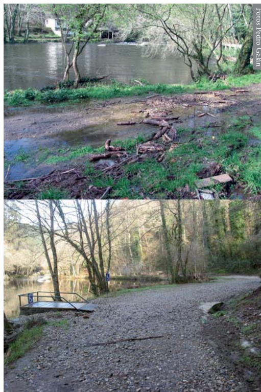
Figura 1. Arriba: encharcamientos estacionales en Chelo, LIC del río Mandeo (la charca principal sólo se aprecia parcialmente, situándose fuera de plano, a la izquierda de la foto; año 2007). Abajo: misma zona después del acondicionamiento de la pista (2008). El drenaje de la cuneta ha eliminado estos encharcamientos estacionales.
